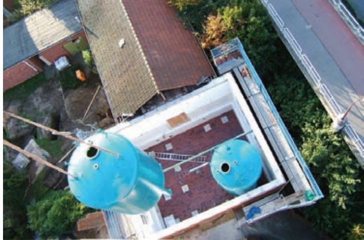
Montage der neuen Filterbehälter
