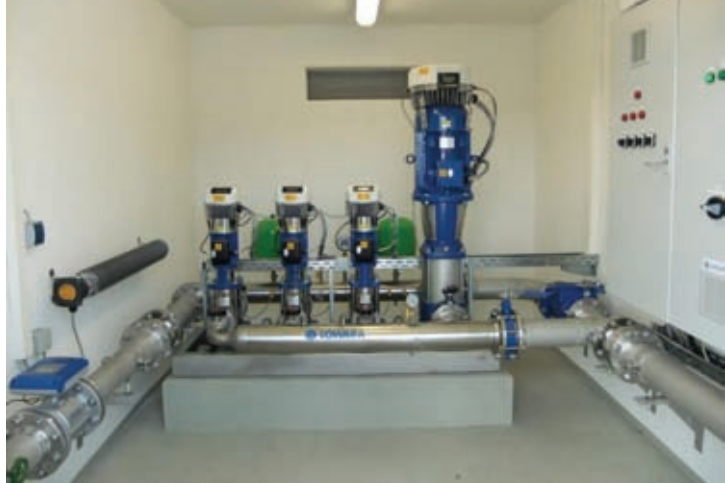
Druckerhöhungsanlage
