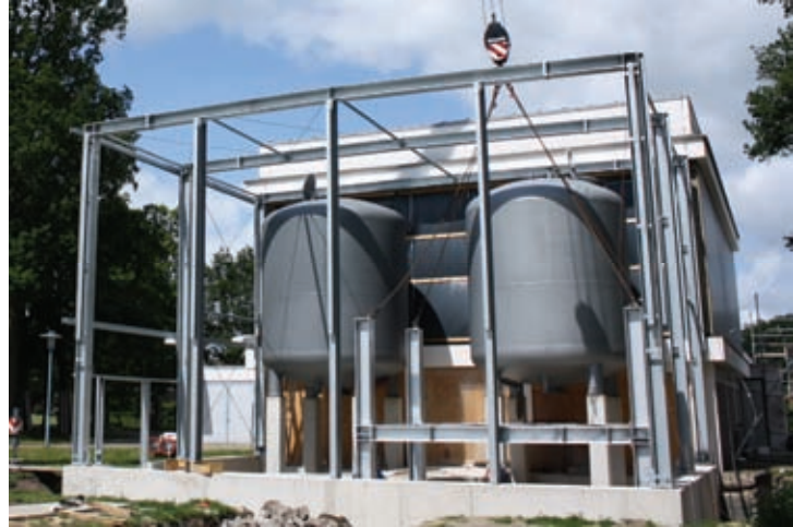
Aufstellung der neuen Filterbehälter
