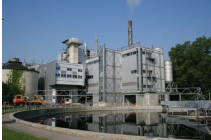
Gebäude der thermischen Schlammbehandlung
