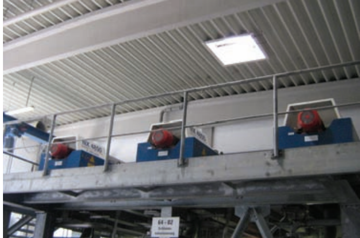
3-straßige Entwässerungsstufe vor der Erneuerung
