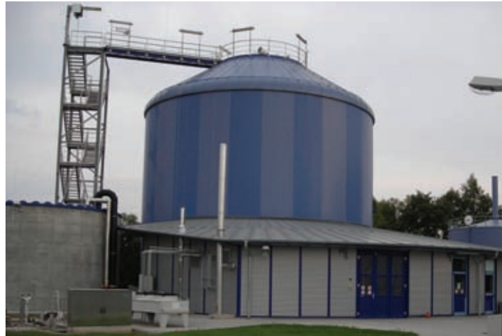
Schlammfäulung und Betriebsgebäude
