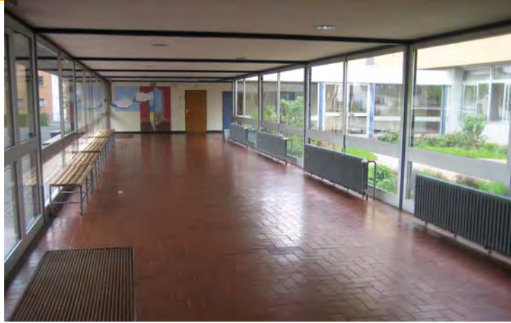
Innenansicht vorhandenes Gebäude
