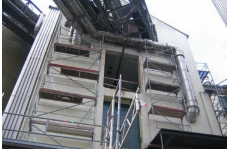
Einbringöffnung für die Kompressoren im 3. OG
