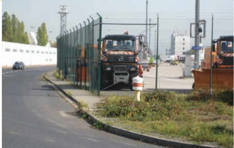
Flughafen Frankfurt, Hydrant zur Brauchwasserversorgung
