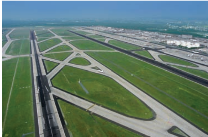
Flughafen Frankfurt am Main (Foto: Fraport AG)
