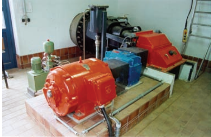
Wasserkraftturbine im Auslaufbauwerk
