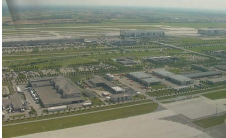
Energiezentrale Flughafen München
