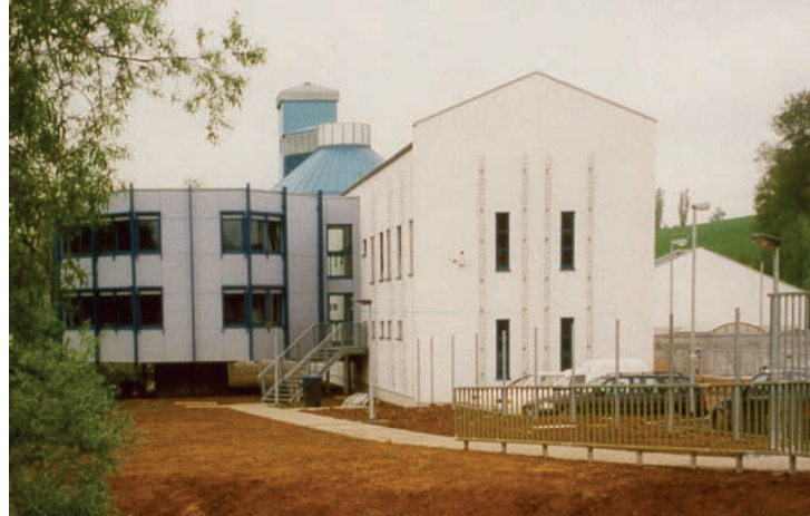
Betriebsgebäude und Anbau Verwaltung
