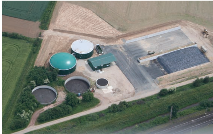
Luftbild der Biogasanlage
