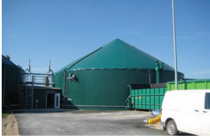
Ansicht der Biogasanlage Bad Nenndorf
