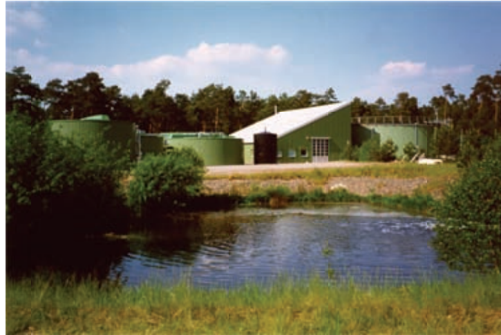
Sickerwasserreinigung für die Deponie Borg im Bau
