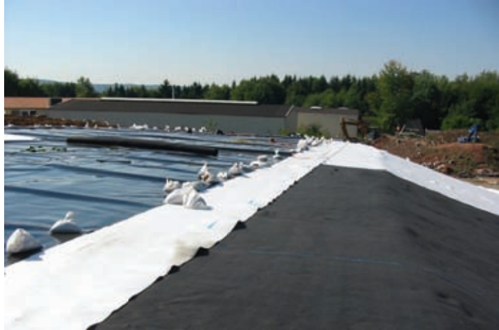
Aufbringung Oberflächenabdichtung
