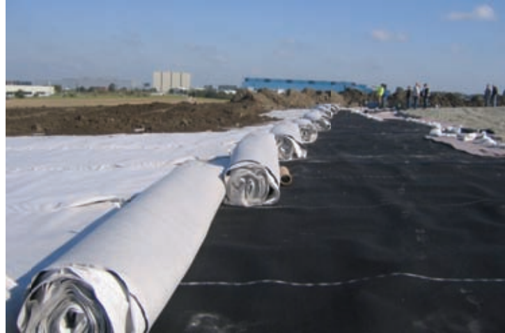
Dränmatten-Rollen auf Kunststoffdichtungsbahnen
