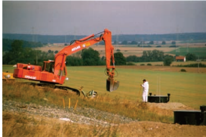
Einbau der Gaserfassungselemente
