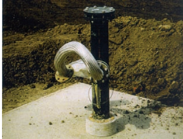
Gaserfassungsbrunnen im Bau
