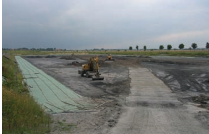
Restverfüllung Polder West
