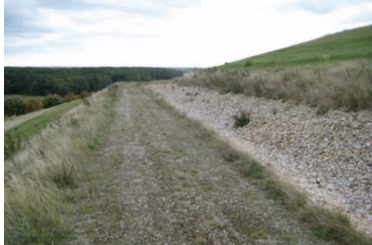
Berme im Bereich der vorh. temporären Abdeckung
