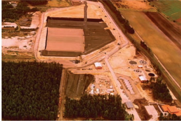
Bauarbeiten an der Abfallentsorgungsanlage Höfer
