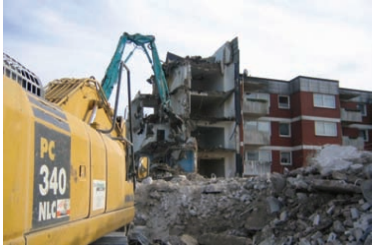
Rückbau „Schwarzer Container“ Block D1 bis D3
