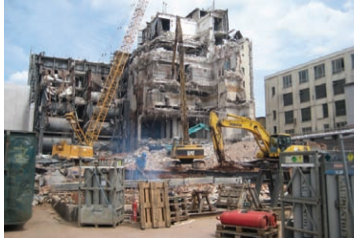
Rückbau Weserkeller mit liegenden Stahltanks
