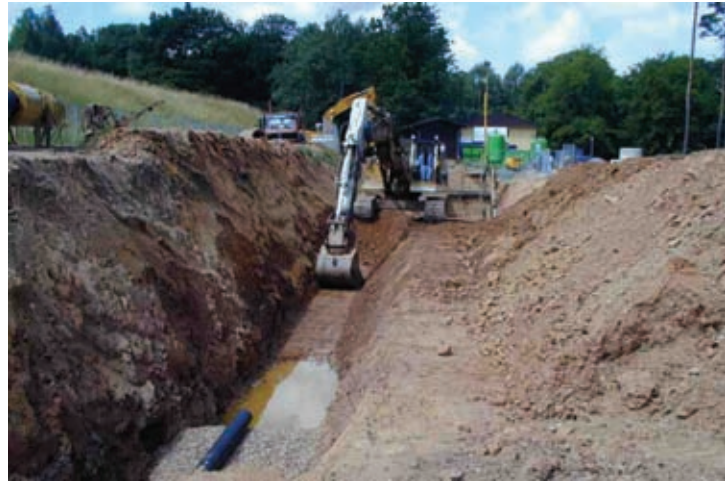
Bau eines Drängrabens
