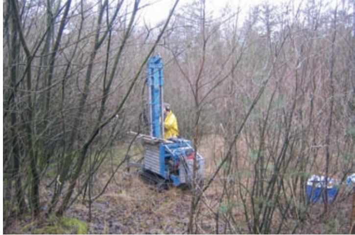
Bohrgerät auf zugewachsenem Sprengtrichter
