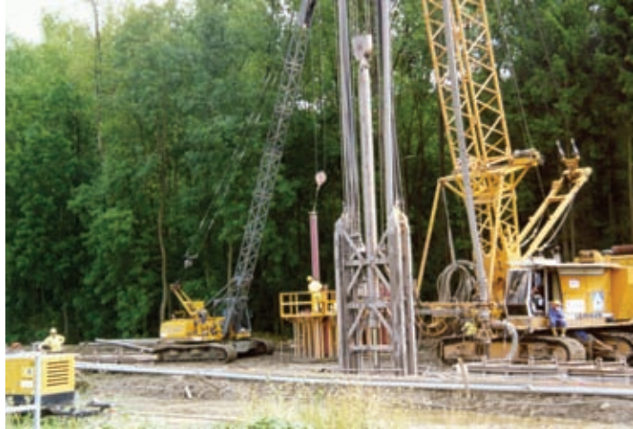
Fräsrahmen im Dichtwandschlitz
