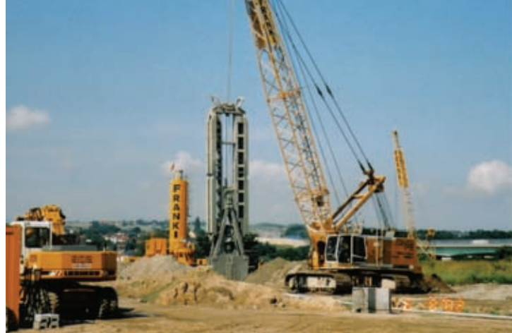
Spundwandeinbau im Schachtgreiferverfahren
