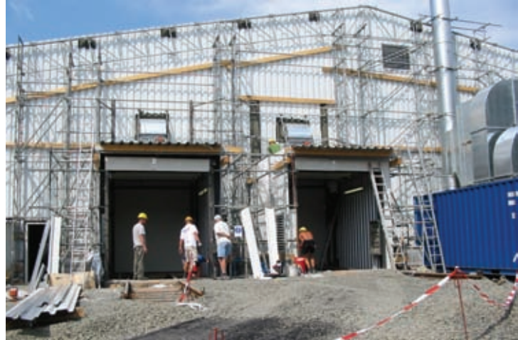
Einhausung mit Schleusen und Abluftbehandlung
