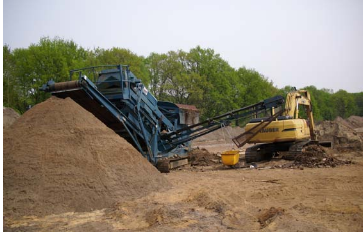
Bodensiebanlage mit Magnetabscheider
