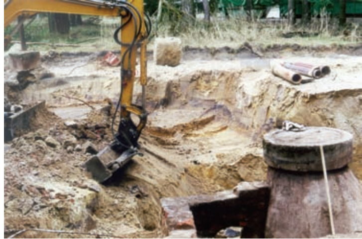
Aushub einer Sanierungsbaugrube
