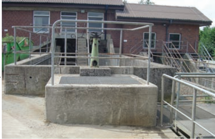
Kläranlage Heppenheim, Schneckenpumpwerk
