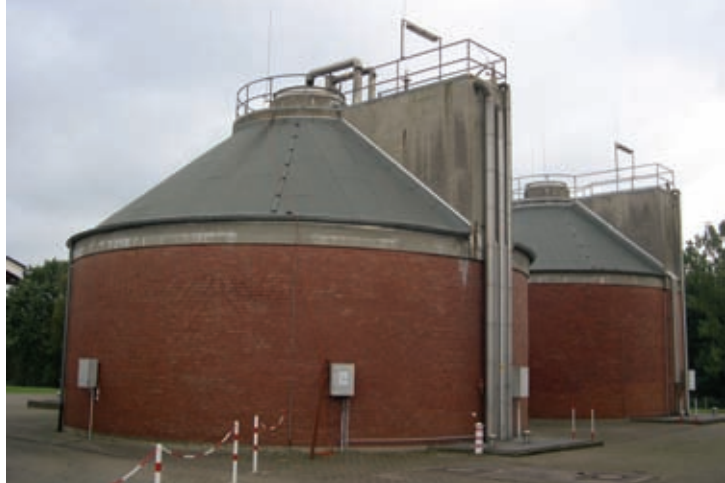
Faulbehälter II, ARA Zeven
