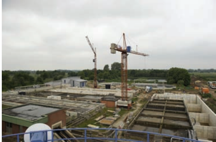
Übersicht das Baufeld der Kläranlage
