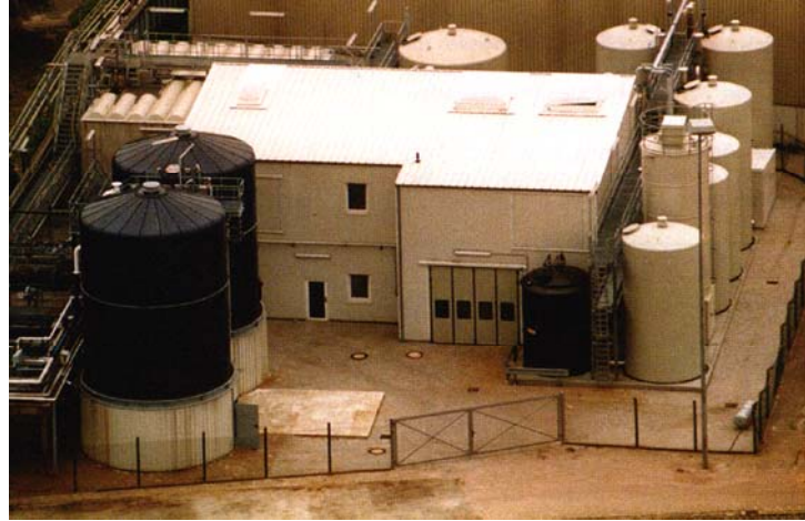
Luftaufnahme der Abwasserbehandlungsanlage
