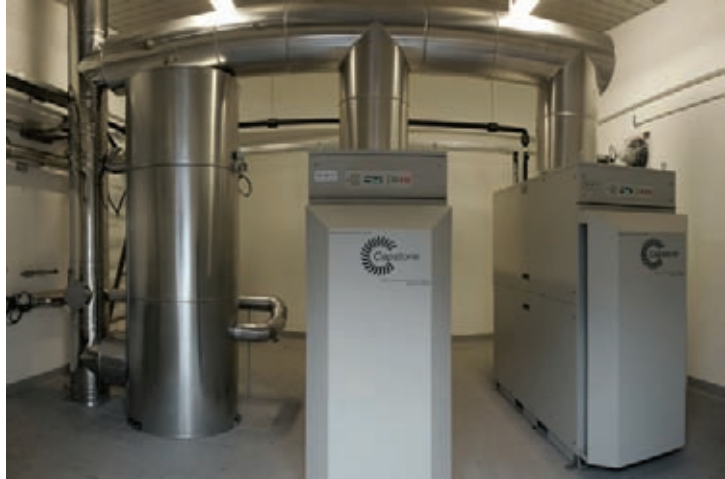
2 Mikrogasturbinen a 65 kW el
