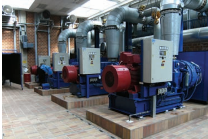
HV-Turboverdichter (4 x 17.000 Nm 3 )
