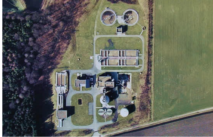
Luftbild der Kläranlage Bielefeld-Sennestadt
