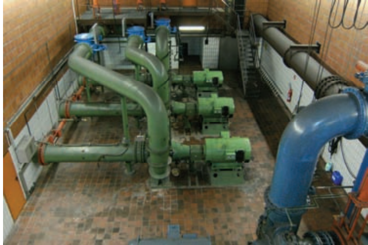
Pumpwerkshalle vor der Sanierung
