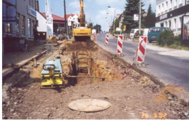
Kanalbau Wilsdruffer Straße
