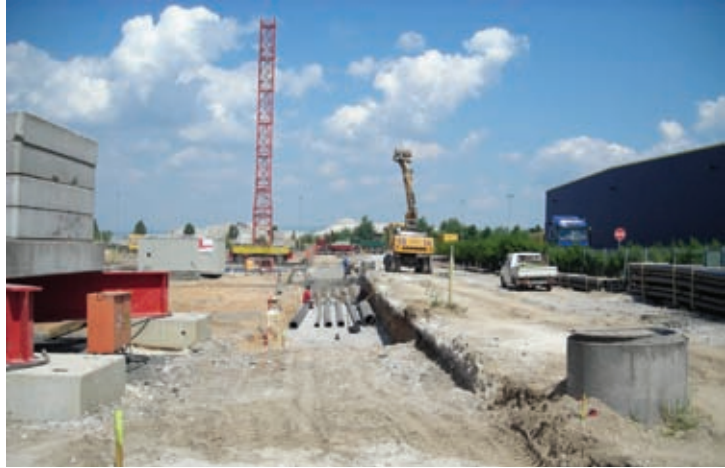
Verlegung der Abwasserdruckleitungen
