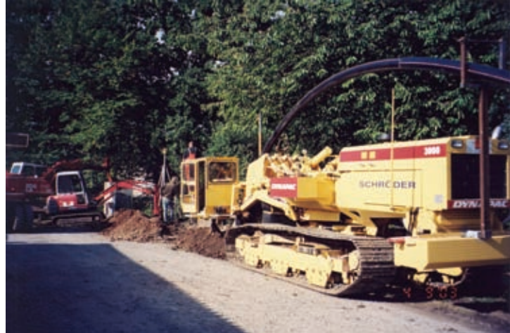
Bau der Druckleitung
