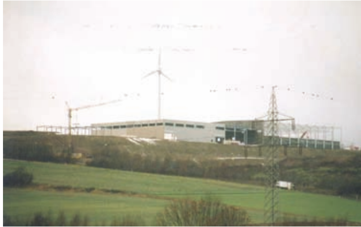
Ansicht der MBA im Bau
