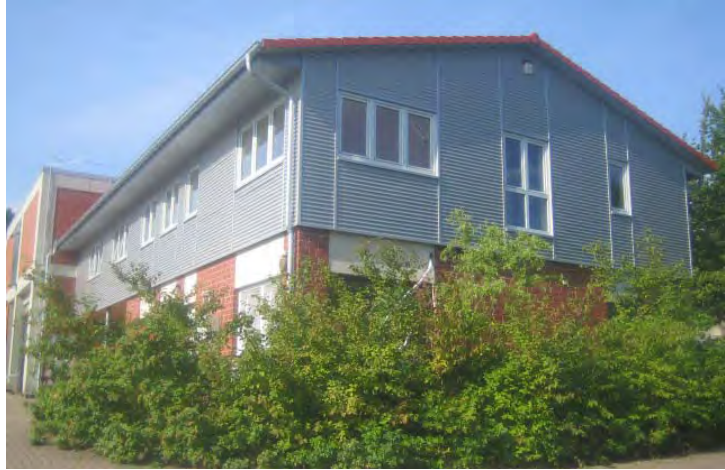
Betriebsgebäude Kläranlage Harsefeld
