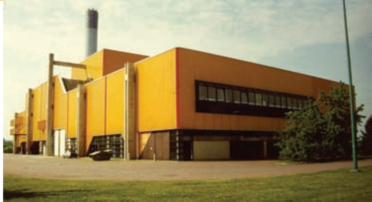
Schlammwässerungs- und Verbrennungsanlage (SEVA) in Frankfurt
