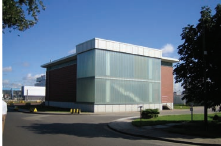
Schaltanlagegebäude auf Köhlbrandhöft
