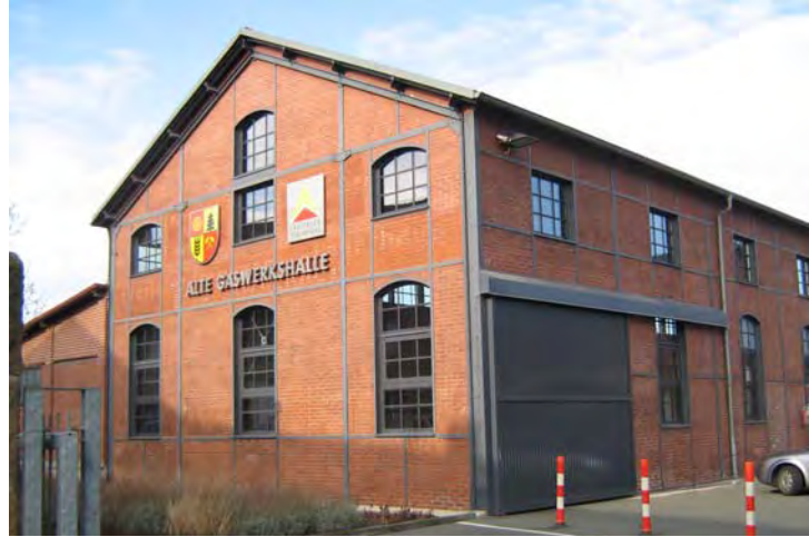
Umbau und Sanierung Gaswerkshalle
