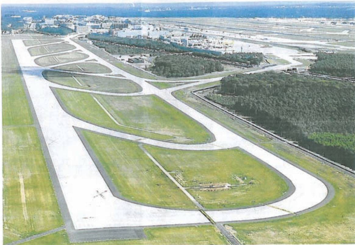
Die Nordwest-Landebahn: Über zwei Brücken ist sie mit dem bisher bestehenden Bahnsystem (rechts oben im Bild) verbunden.
