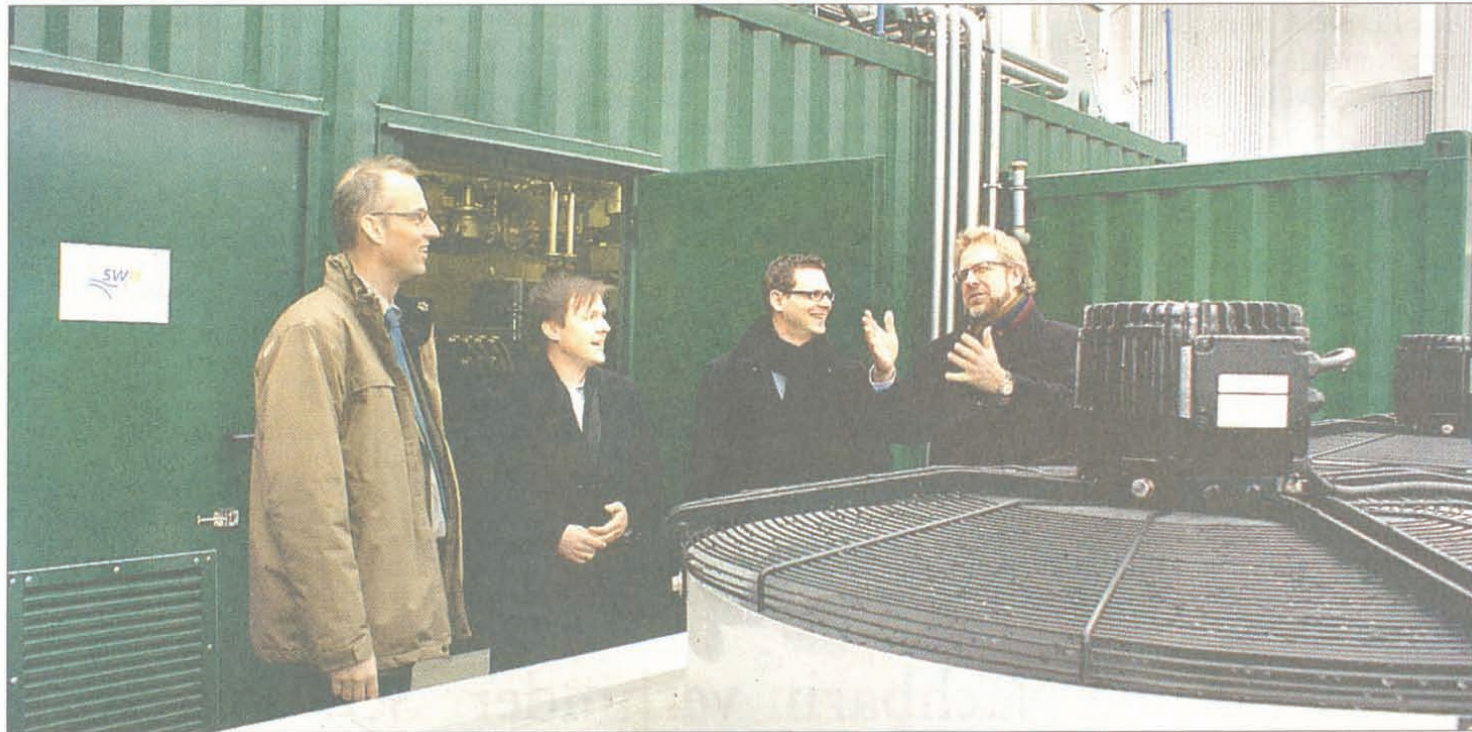
Bestaunen das neue Blockheizkraftwerk: (v.l.) Adelbert Lühring (Planungsbüro Born&Ermel), Markus Stumpe (Technischer Leiter CSM), Thomas Saueremann (CSM-Werksleiter) und Hans-Ulrich Salmen (Geschäftsführer SWD-Gruppe). BILD: RESENSKI
